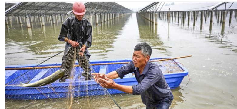
Halastavakra telepített napenergia hasznosító telepek
